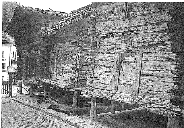
Abb. 6. Grimentz, Wallis/Schweiz. Speicherbauten an der Hauptstrasse.
