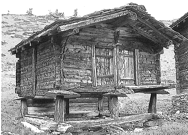
Abb. 1. Zermatt-Findeln, Wallis/Schweiz. Heute leerstehender Getreidespeicher.
