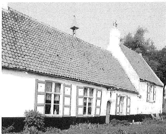
Fig. 2. Bâtiment principal d'une ferme de la région côtière (environ de Bruges) avec à droite la partie surélevée comprenant la cave semi-enterrée et la chambre haute.
