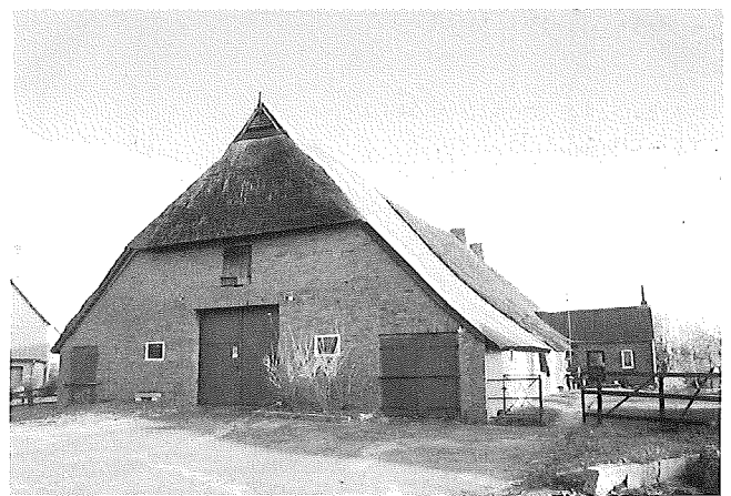
Abb. 1. Giebel des 20. Jahrhunderts des Hauses in Schwinde (Foto U. Klages 1986).
