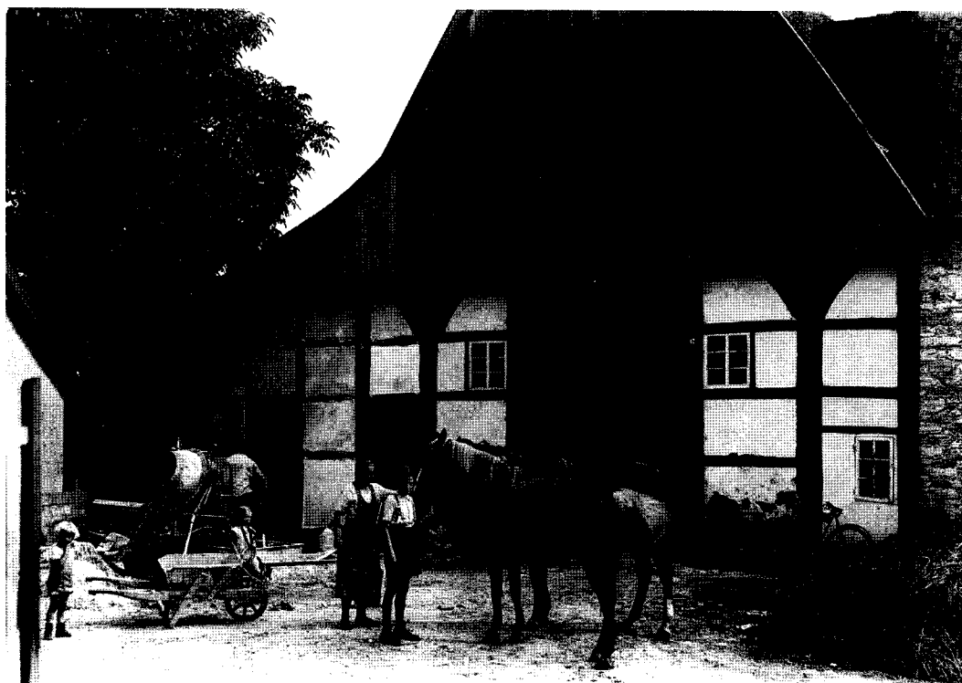
Abb. 5. Heidenoldendorf (Stadt Detmold), ehem. Hof Mertens Nr. 12. Kötterhaus, 1558/59 (d). Vorgiebel, Zustand während des Umbaus der linken Stallabseite, 1937. Foto: Westfälisches Amt für Denkmalpflege, Münster.
