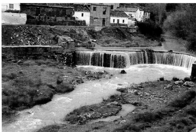
Fig. 1b. Media Luna de los Castillejos (Pinos Puente, province de Grenade). Ce barrage monumental, en pierre de taille, permet la dérivation partielle du río Cubilas par deux canaux, l'acequia del Vadillo.
