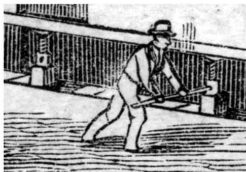
Abb. 12 Fig. 1 bis 3 zu Anonymus: *How to Move Houses* 1873 (mit Details: Fig. 2: Drehen der Schraubenwinde, Fig. 3: Ziehen mit Flaschenzug) und oben links Abb. zu vorangehendem Artikel: Loading a tread-power unter Einsatz von Rollhölzern.
