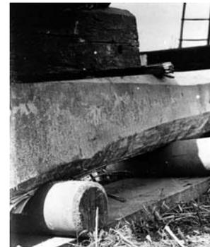
Abb. 6 Rollen unter dem Schlitten, auf dem die *Keirekensmolen* steht, darüber der Kreuzfuß der Mühle.
