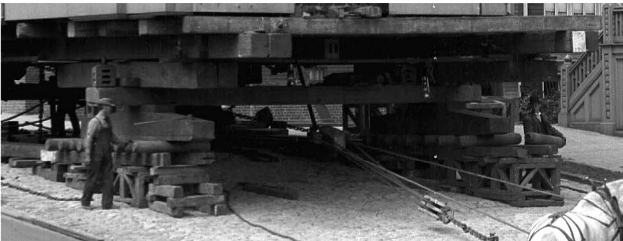
Abb. 9 Schieben eines Hauses mittels Ziehen von vorne in San Francisco um 1900, mit zwei jeweils mit einem Pferd betriebenen Ankerwinden und an einem Festpunkt montierten Flaschenzügen, unten Detail mit Rollen.
