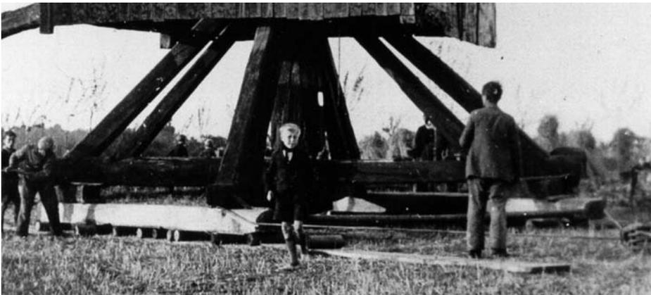
Abb. 5 Der Schlitten mit der *Keirekensmolen* wird auf Rollen nach rechts gezogen, eine Rolle wurde gerade wieder vorgelegt. Rechts sind Flaschenzüge zu erkennen.
