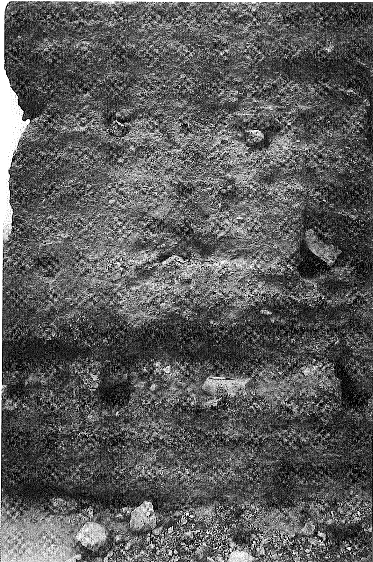
Fig. 4. Détail de la construction en tâbiya de la tour nord-est de l'enceinte.
