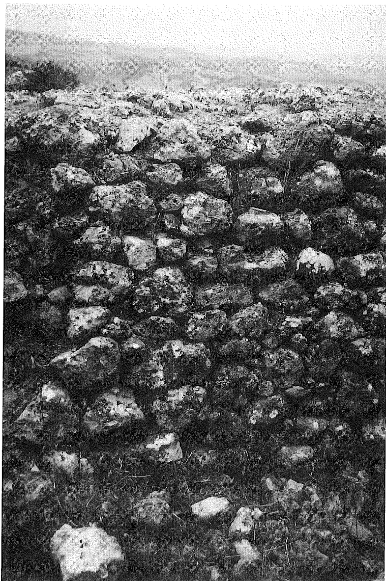
Fig. 6. Le second mur d'enceinte, avec un parement en petit appareil irrégulier de moellons.
